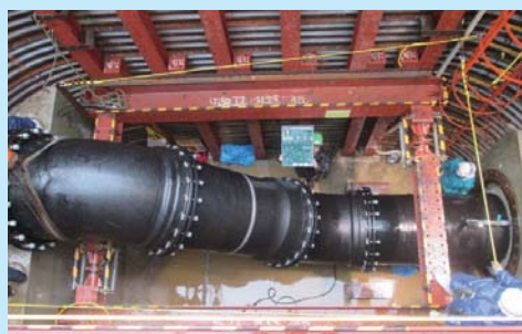
水道配水管更新工事
