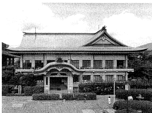
市公会堂東館(昭和5年[1930])
