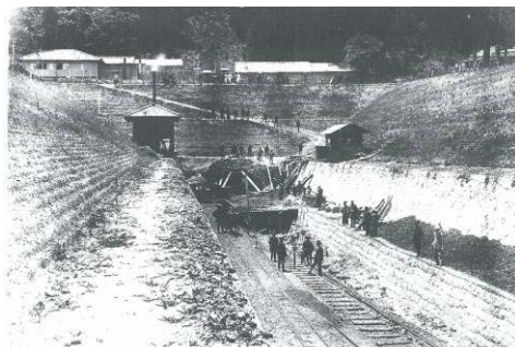
第1疏水工事の様子
