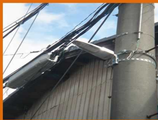
本年度設置した防火防犯街灯
