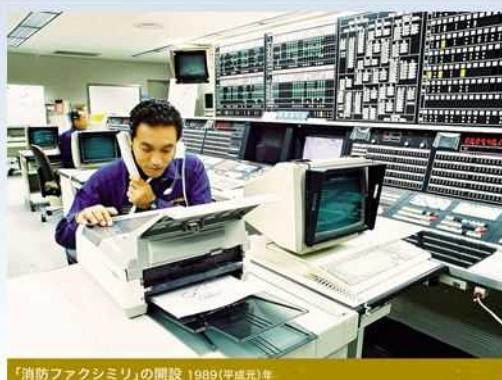
「消防ファクシミリ」の開設 1989(平成元年)
