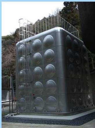
消防局では、震災消防水利整備計画（平成15年11月策定）に基づき、耐震型防火水槽（以下「防火水槽」という。）（100m<sup>3</sup>、60m<sup>3</sup>、40m<sup>3</sup>）及び防火井戸を整備しています。
