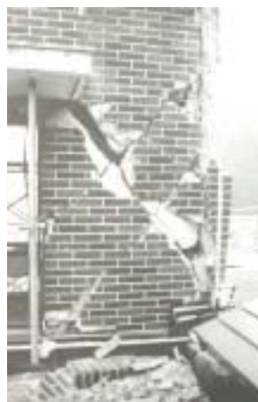
図 - 3.4 損傷度大破のイメージ 2)
