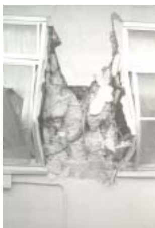
図 - 3.4 損傷度大破のイメージ 2)
