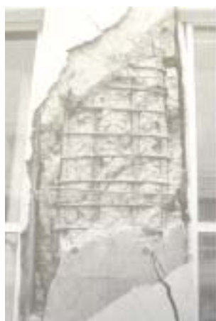
図 - 3.3 損傷度中破のイメージ 2)
