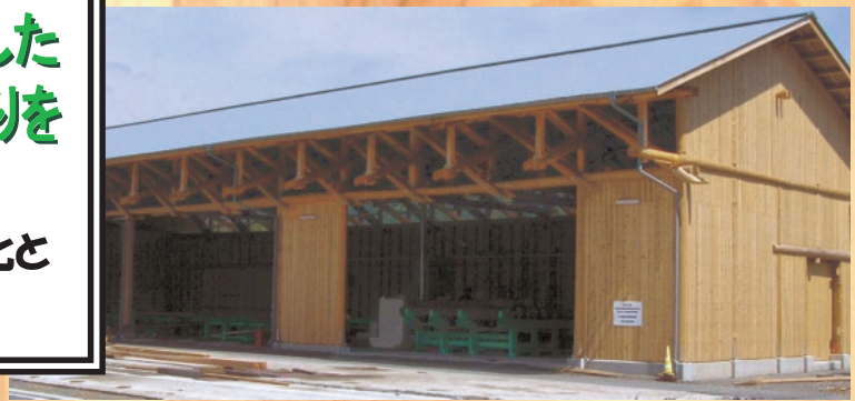
杉丸太を使用したトラス工法による作業用建物
