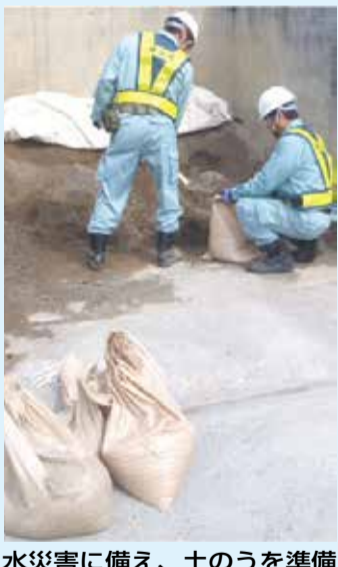
水災害に備え、土のうを準備
