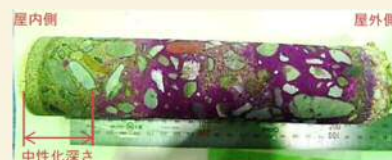
【コンクリートの中性化深さ】
