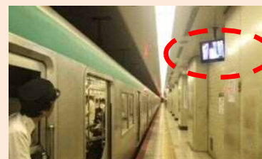
ホーム車掌用モニター設備の増設
