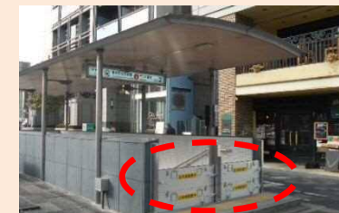
駅出入口への止水板の設置
