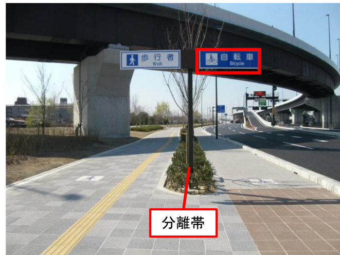
竹田街道：阪神高速8号京都線鴨川西出入口
