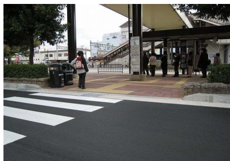
【段差 1 c mの事例】
