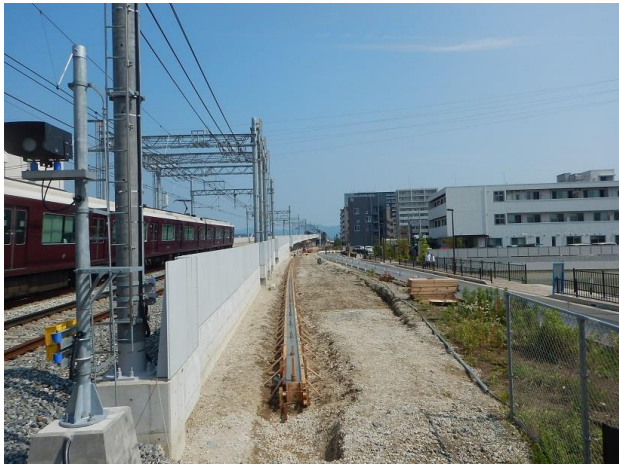
第一工区 向日市域部分（施工箇所を撮影）
