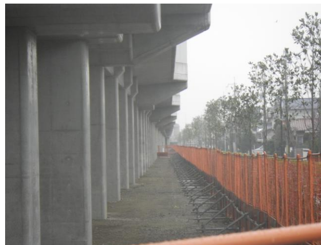
平成29年 1月撮影 （6月も状況に変化なし）
