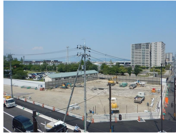
第一工区 久世北茶屋線復旧部分（作業状況を撮影）
