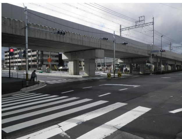
第三工区 P33川岡下三番踏切（東→西を撮影）
