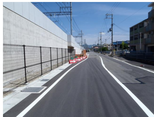
第三工区 高架下フェンス施工部分（南→北を撮影）
