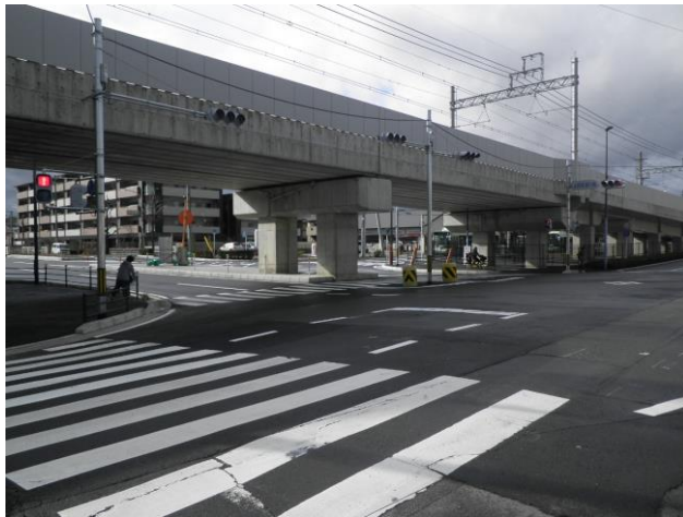
第三工区 P 3 3 川岡下三番踏切 (東→西を撮影)
