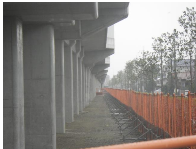
第二工区 西側道部分（北→南を撮影）
