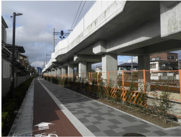
第三工区 R c 2 6 (南→北を撮影)
