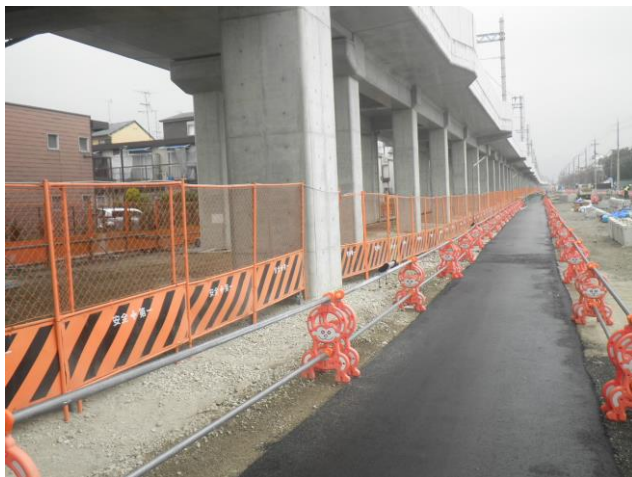
第二工区 交差点部分（南→北を撮影）
