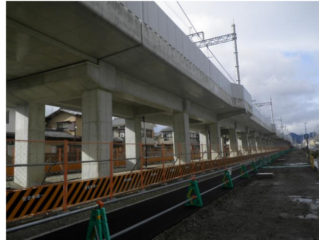
第三工区 高架部分 (南→北を撮影)
