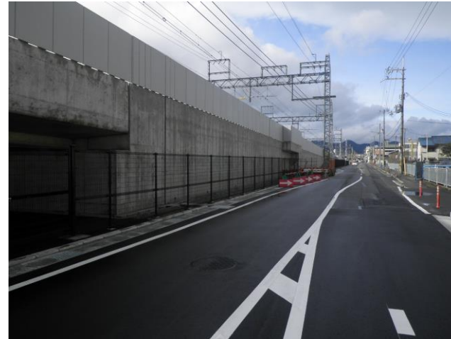
第三工区 高架下フェンス施工部分 (南→北を撮影)
