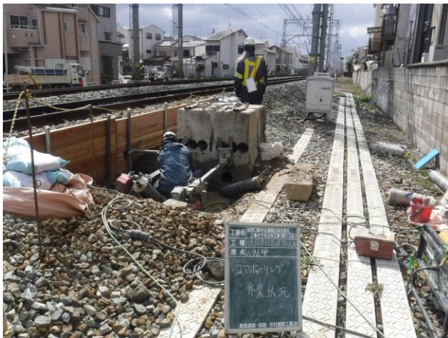
第一工区 向日市域部分（作業状況を撮影）
