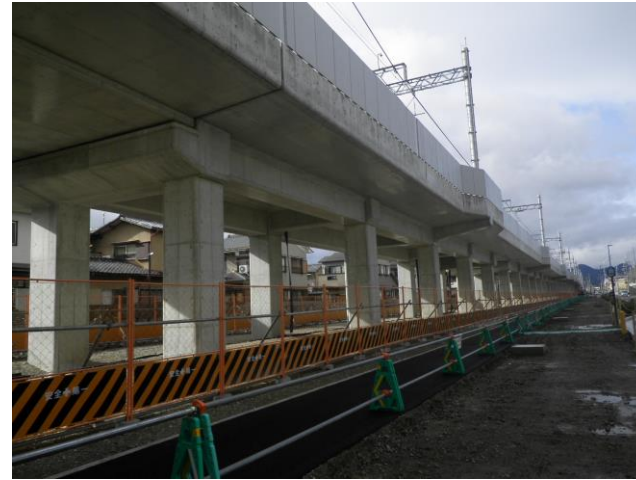
第三工区 高架部分 (南→北を撮影)
