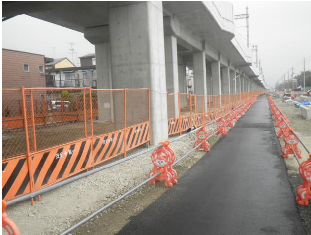
第二工区 交差点部分（南→北を撮影）
