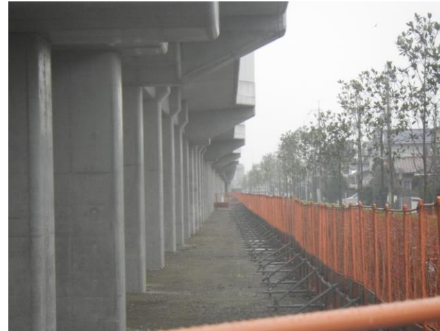
第二工区 西側道部分（北→南を撮影）
