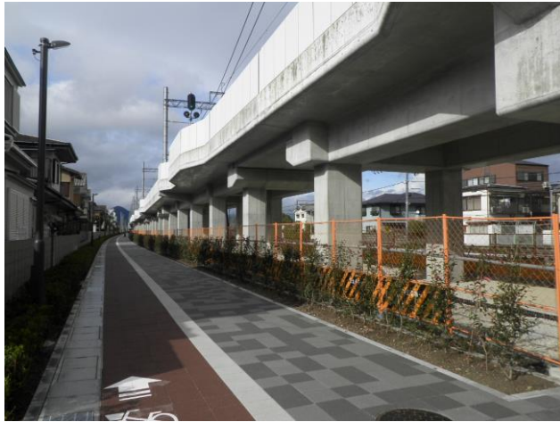
第三工区 R c 2 6 (南→北を撮影)
