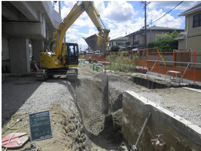
第二工区 地下道部③
