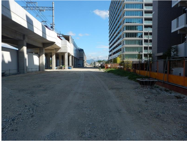
第一工区 仮線路部（南→北を撮影）
