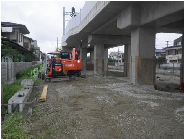
第三工区 R c 2 6 (南→北を撮影)
