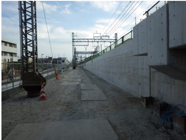
第一工区 向日市域部分（北→南を撮影）
