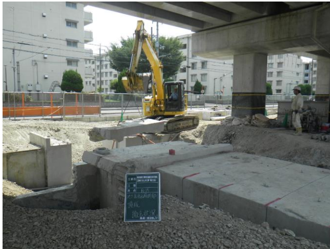
第二工区 地下道部①
