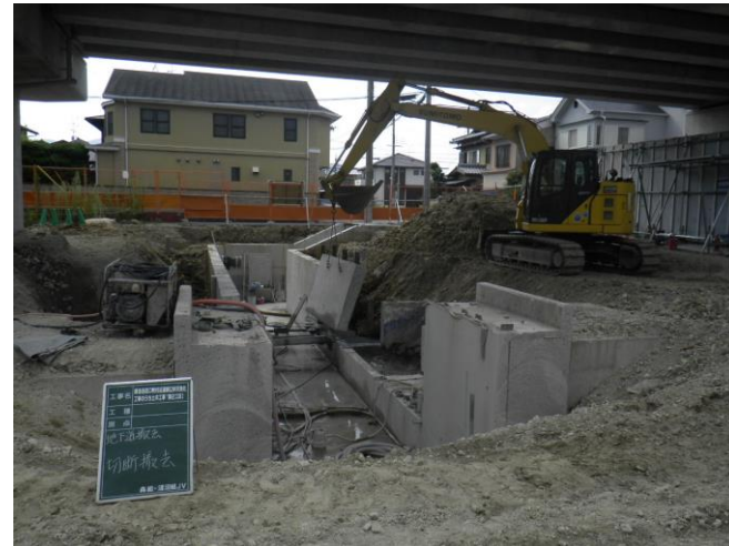
第二工区 地下道部②
