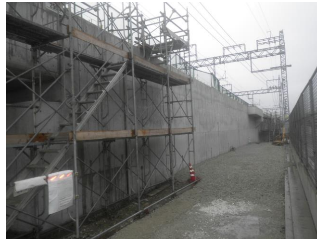
第三工区 桂駅側擁壁施工部 (南→北を撮影)
