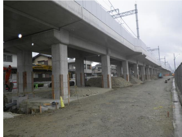
第三工区 R c 2 7 (南→北を撮影)
