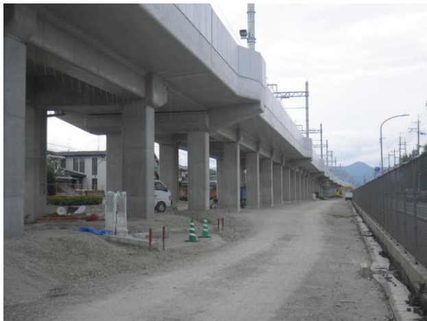
第二工区 仮線路部 (南→北を撮影)
