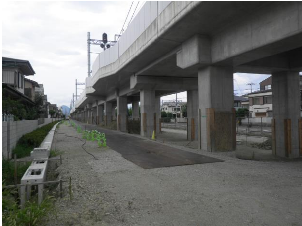
第三工区 R c 2 6 (南→北を撮影)
