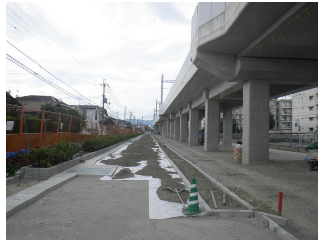
第二工区 Rc16 (南→北を撮影)
