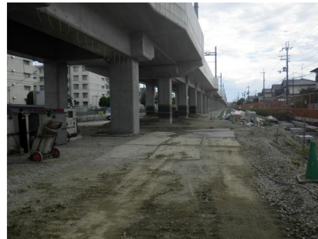
第二工区 Rc24 (北→南を撮影)
