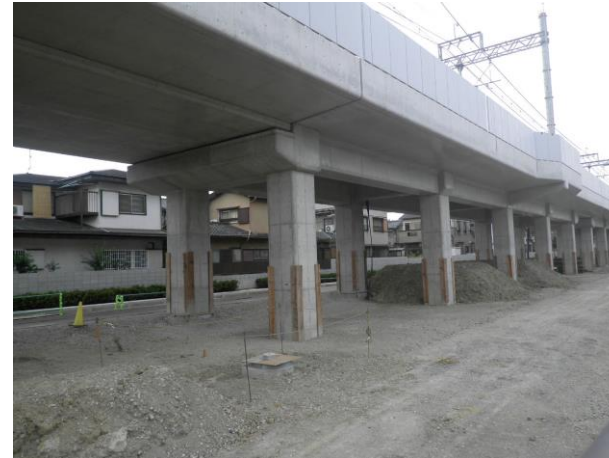
第三工区 R c 2 7 (南→北を撮影)
