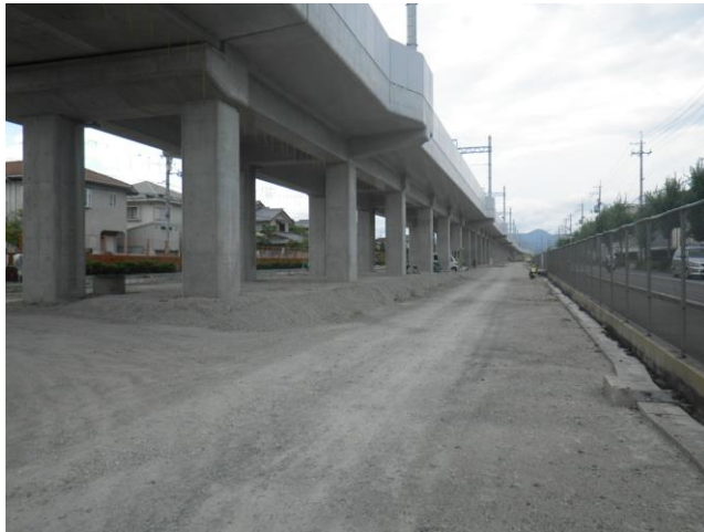
第二工区 仮線路部 (南→北を撮影)
