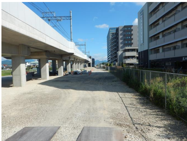
第一工区 仮線路部（南→北を撮影）
