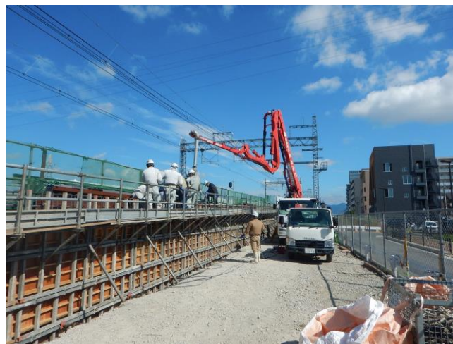
第一工区 向日市域部分（南→北を撮影）
