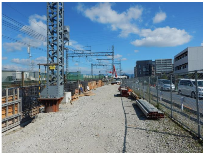
第一工区 向日市域部分（南→北を撮影）
