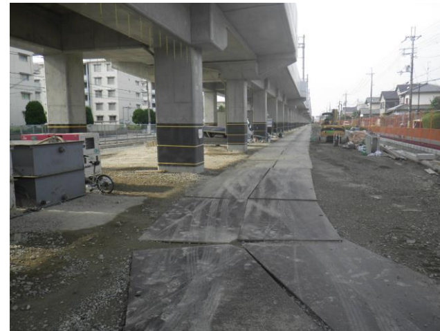
第二工区 Rc24（北→南を撮影）
