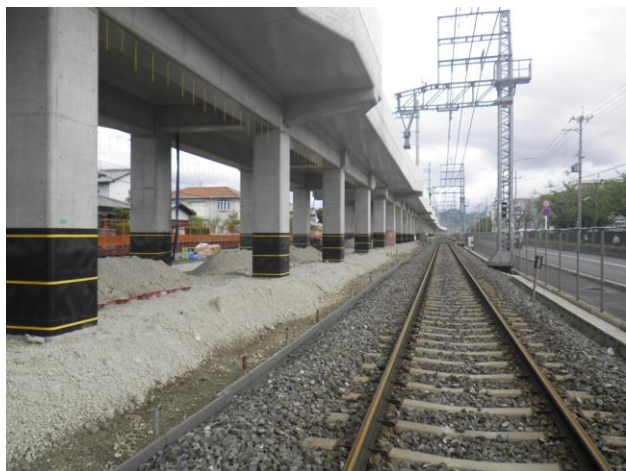
第二工区 仮線路部（南→北を撮影）
