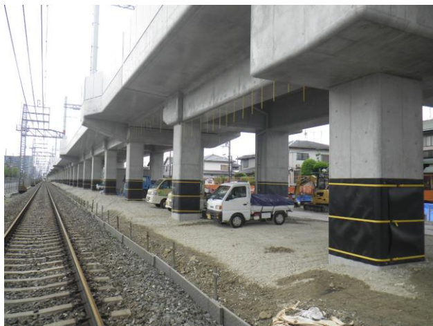
第二工区 仮線路部（北→南を撮影）
