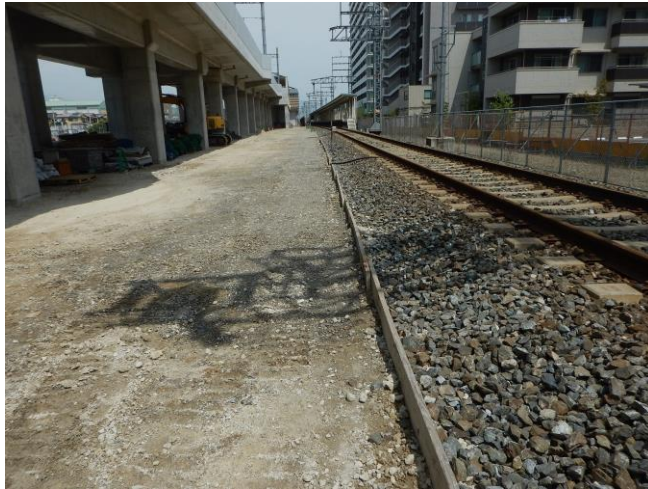
第一工区 仮線路部（南→北を撮影）
