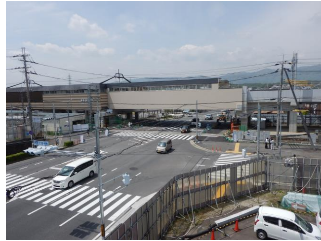
第一工区 物集女踏切道（東→西を撮影）
