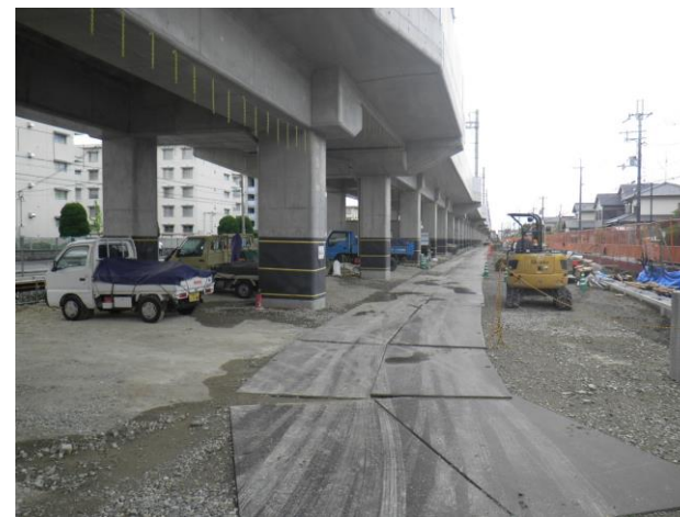
第二工区 Rc24（北→南を撮影）
