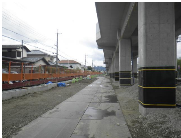
第二工区 Rc16（南→北を撮影）
