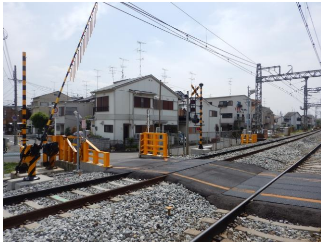
第一工区 変電所上手踏切道（北→南を撮影）
