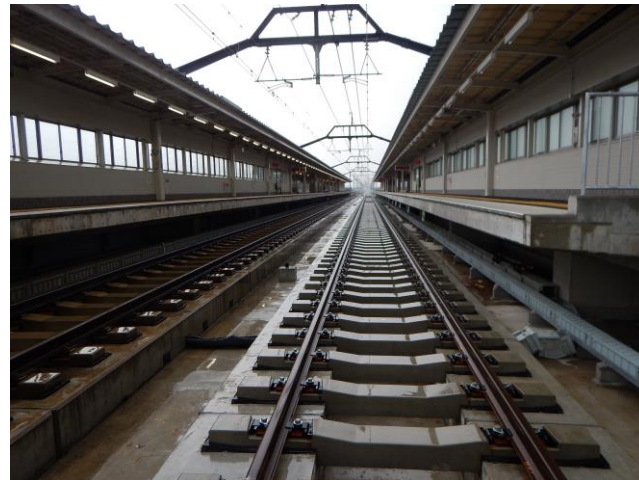
第一工区 ホーム部
