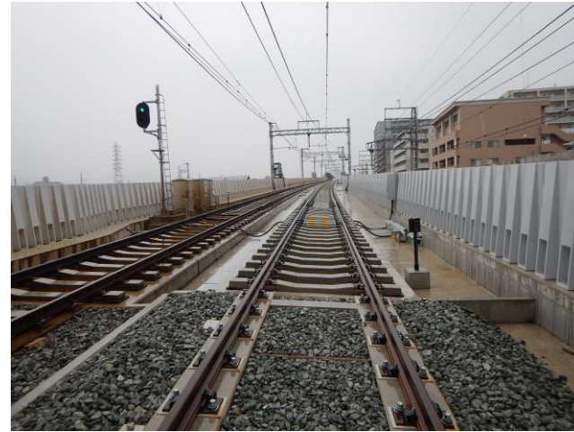
第一工区 Rc5 (南→北を撮影)
