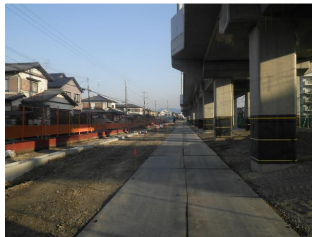
第二工区 Rc16 (南→北を撮影)
