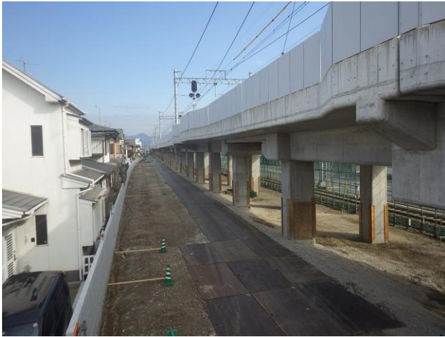
第三工区 R c 2 6 (南→北を撮影)
