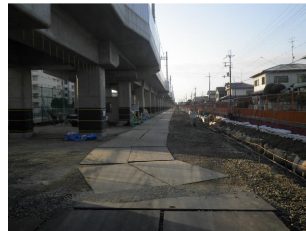
第二工区 Rc24 (北→南を撮影)
