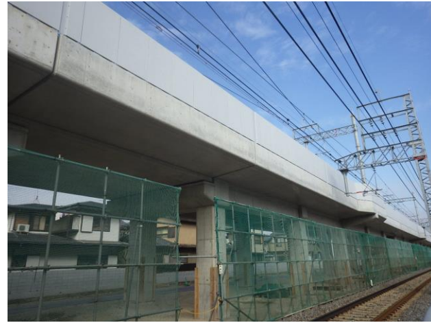
第三工区 R c 2 7 (南→北を撮影)
