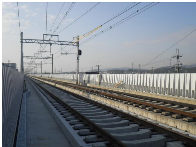
第二工区 Rc15 (北→南を撮影)
