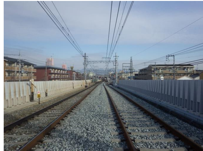
第三工区 R c 3 5 (南→北を撮影)
