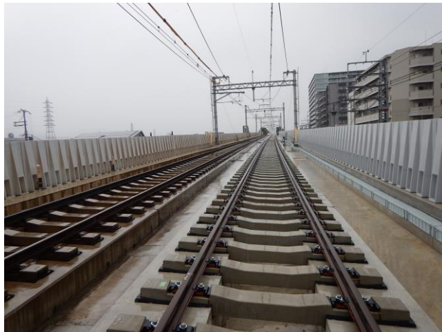
第一工区 Rc7 (南→北を撮影)
