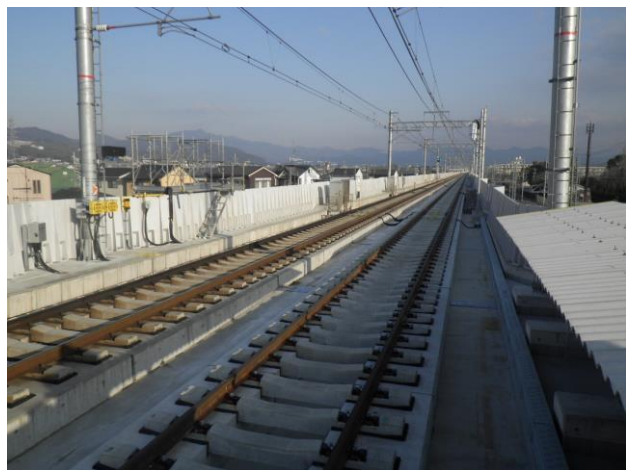
第二工区 Rc17 (南→北を撮影)
