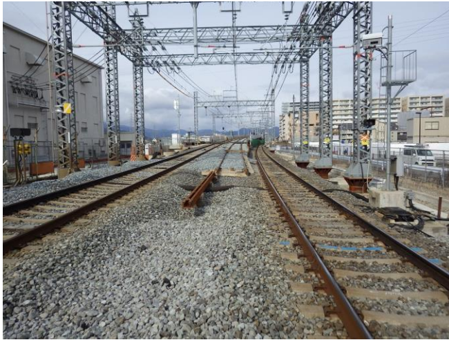
第一工区 起点部 (南→北を撮影)
