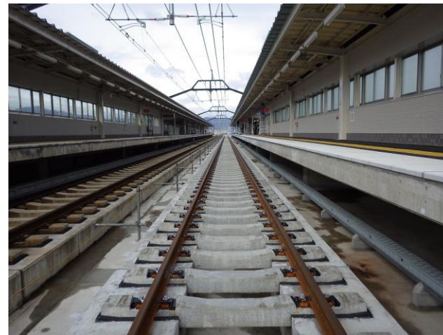
第一工区 ホーム部
