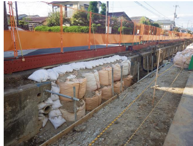
第二工区 側道擁壁撤去状況②
