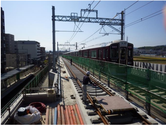
第一工区 起点部（北→南を撮影）
