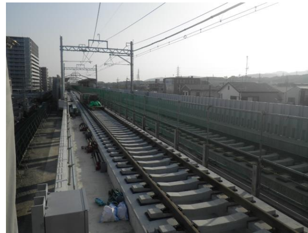
第二工区 Rc14 (北→南を撮影)
