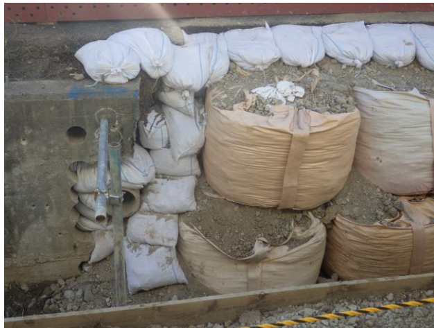
第二工区 側道擁壁撤去状況①
