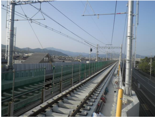
第二工区 Rc14 (南→北を撮影)
