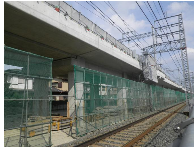
第三工区 Rc27 (南→北を撮影)
