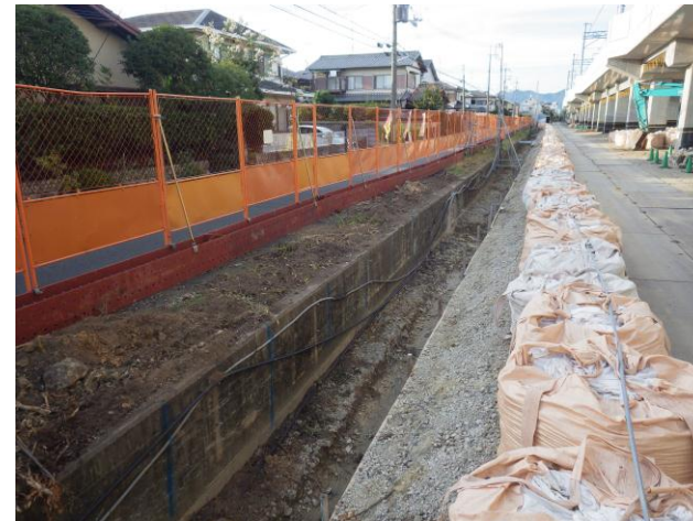
第二工区 側道擁壁撤去状況②
