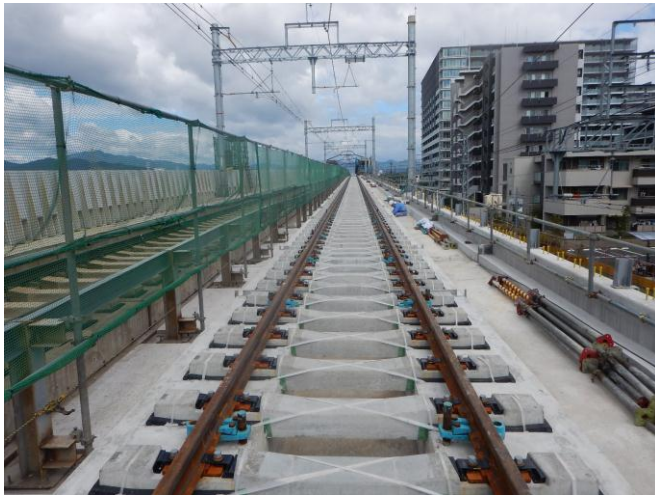
第一工区 Rc 5（南→北を撮影）
