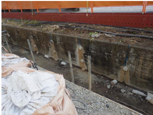
第二工区 側道擁壁撤去状況①
