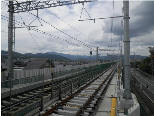
第二工区 Rc14 (南→北を撮影)
