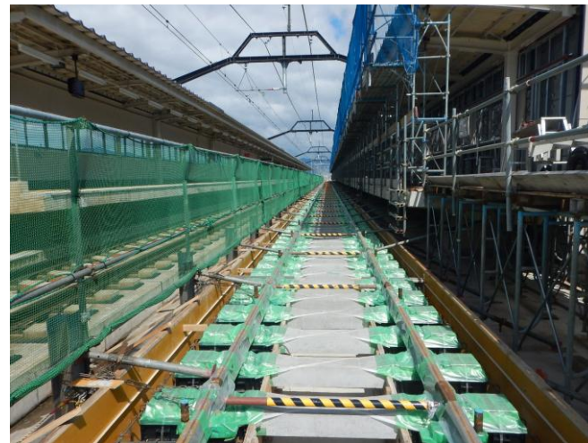
第一工区 Rc 9（ホーム部を撮影）
