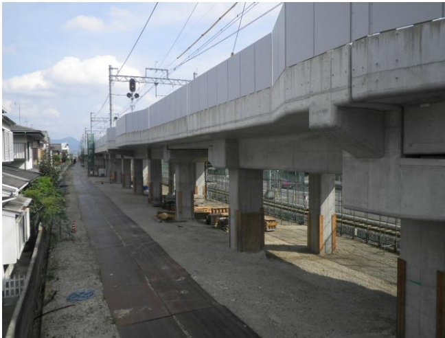
第三工区 Rc26 (南→北を撮影)
