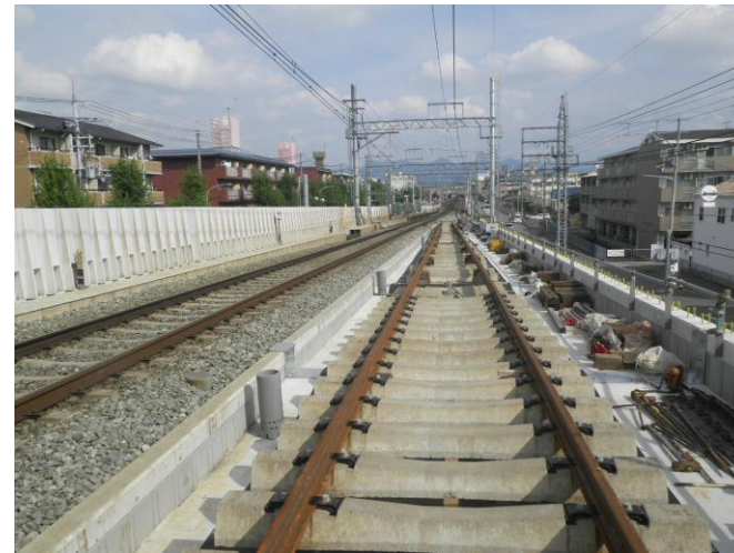
第三工区 Rc35 (南→北を撮影)
