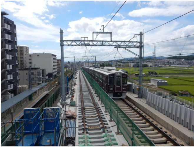
第一工区 起点部（北→南を撮影）
