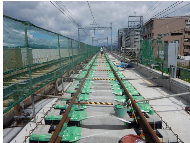
第一工区 Rc 3（南→北を撮影）
