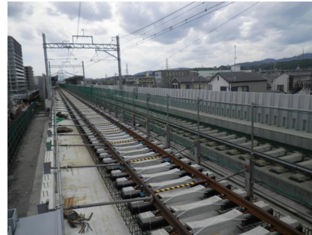
第二工区 Rc14 (北→南を撮影)
