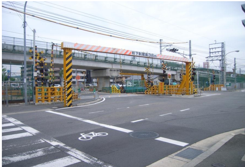
第三工区 Ph32・33 (南→北を撮影)
