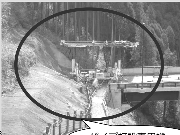
パイプ打設専用機
