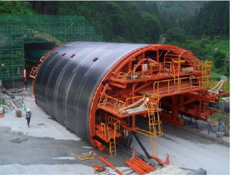
覆工コンクリート型わく(セントル)
