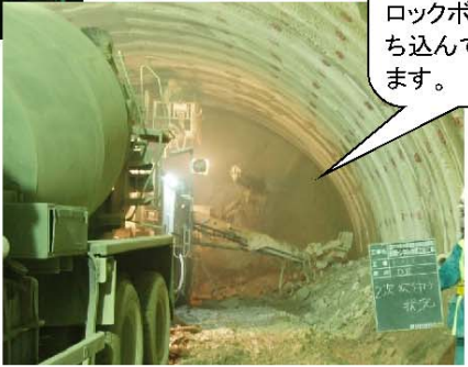
コンクリート吹付け、ロックボルト
