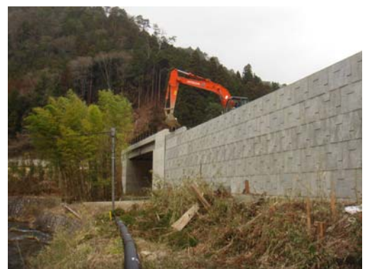
（その2工事進捗状況）
