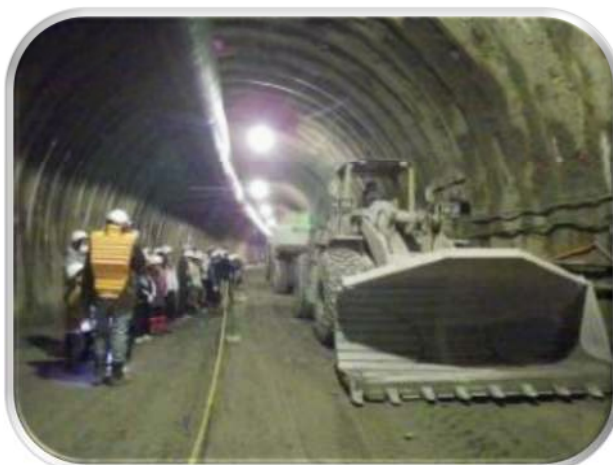
トンネル坑内見学(機械の説明など)
