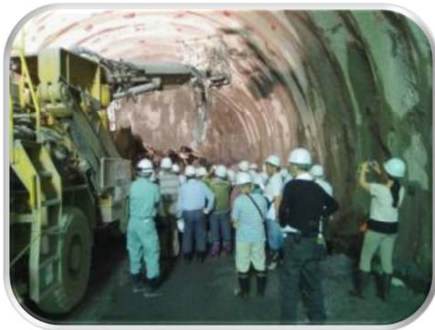
トンネル坑内見学(掘削先端部付近)
