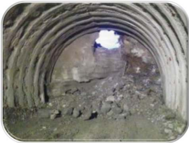
貫通の瞬間(トンネル内から)
