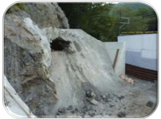
貫通の瞬間(終点側から)
