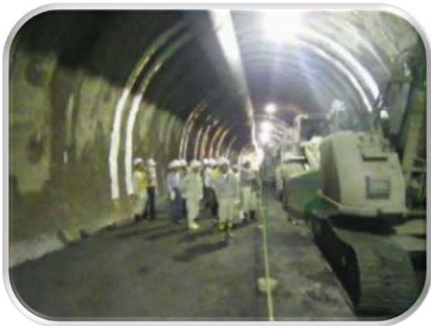
トンネル坑内見学(建設機械紹介)
