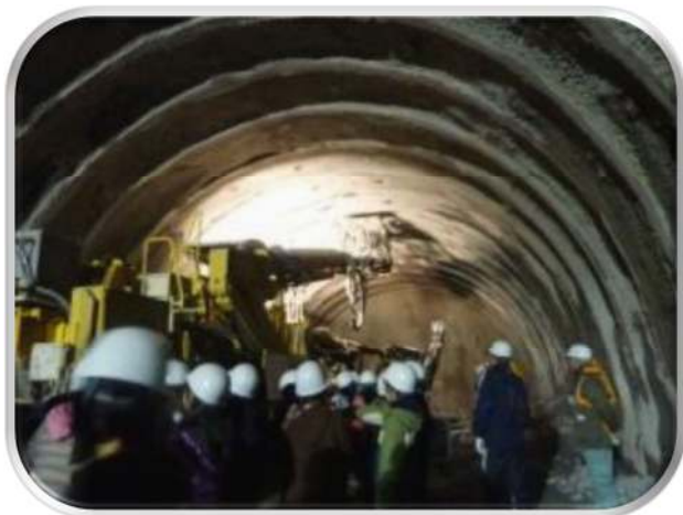
トンネル坑内見学(掘削先端部付近) ※トンネル坑口から約276m
