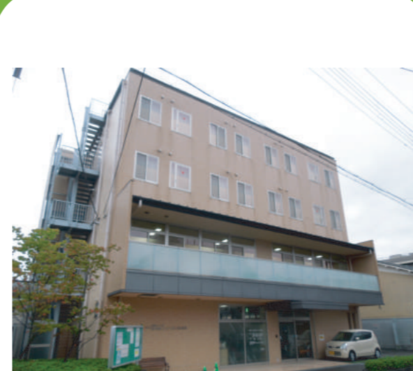
延床面積：2,776 m 2 （4階建） 建築年：2008年 主な設備：空調、照明、エレベータ、 エコキュート、医療機器
