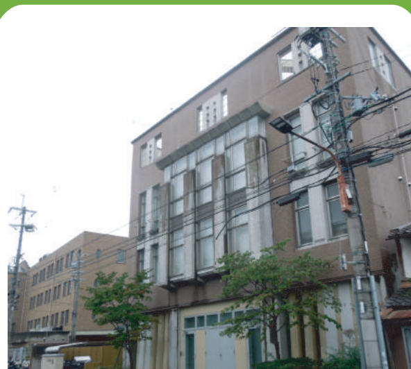
BEMS 導入建物：翔志館 延床面積：1,634 m 2 （4階建） 主な設備：空調、照明
