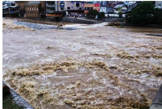
2013年の台風18号による鴨川増水の状況
