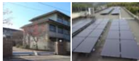
<大原野中学校（発電出力60kW）>
