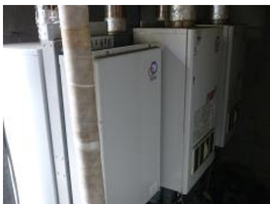
給湯用ボイラー
