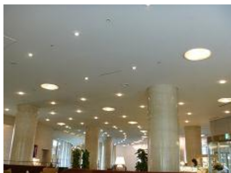
ロビースペースの LED 照明
