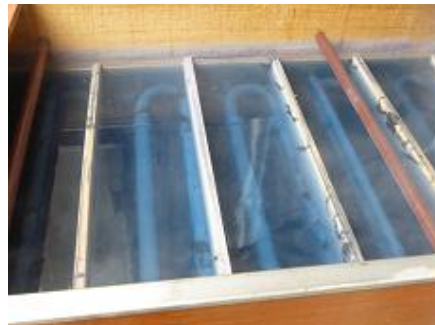
ラフ熱交換器内部
