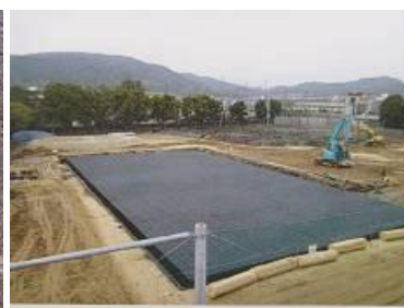
雨水抑制水槽
