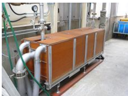
ラフ熱交換器外観
