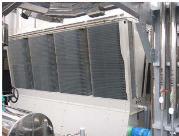
更新後の空調熱源設備（チラー）
