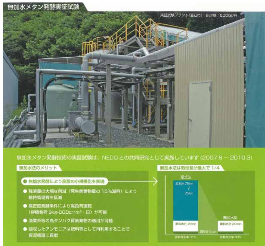
図 2.2-8 大成建設の無加水メタン発酵実証試験設備（釜石市）
