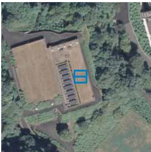
06ND6534-01 *0.5 山科区 厨子奥花鳥町 京都市上下水道局 蹴上浄水場
