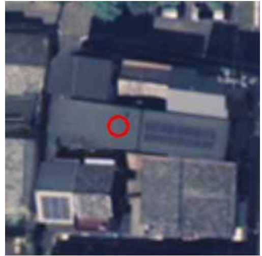
06ND6433-07 *2 中京区 壬生高樋町
