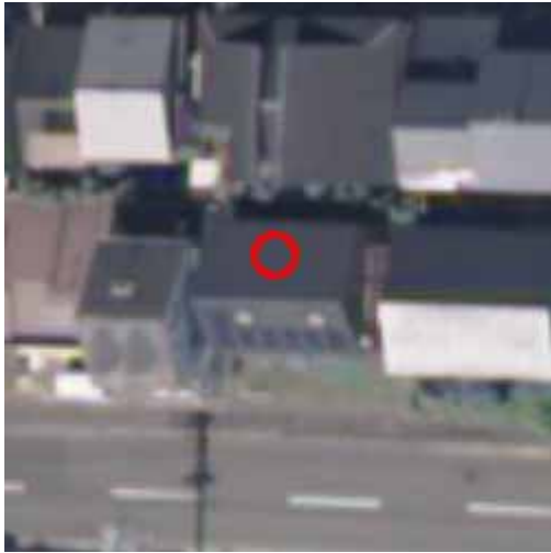
06ND5514-06 *2 左京区 一乗寺清水町 遊夢 CT 発電所
