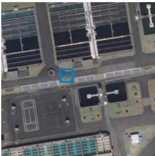
06ND5513-01 *0.5 左京区 松ヶ崎久土町 京都市上下水道局 松ヶ崎浄水場
