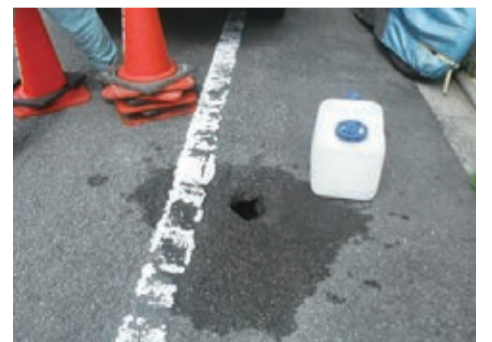
重大な事故につながる道路陥没
