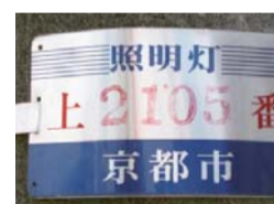
照明灯プレートの記載例
