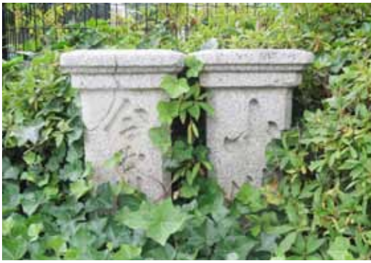
小川橋の親柱
