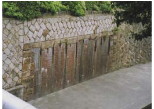
北野線中立売鉄橋橋台
