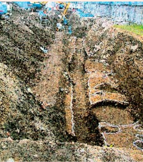
溝18全景 (南より撮影)
