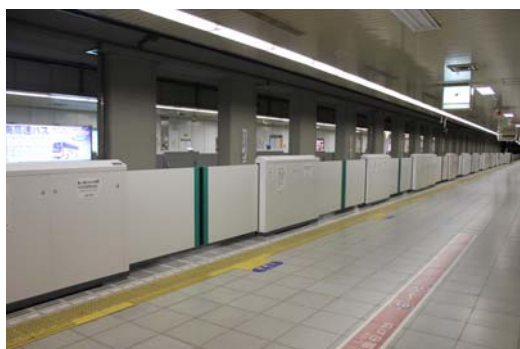
＜地下鉄駅における可動式ホーム柵の設置＞
