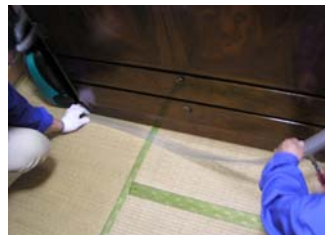
家具転倒防止板の設置
