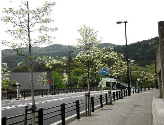
電線類地中化事例（三条通蹴上付近）
