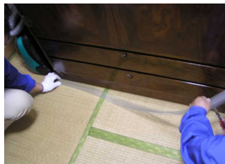
家具転倒防止板の設置
