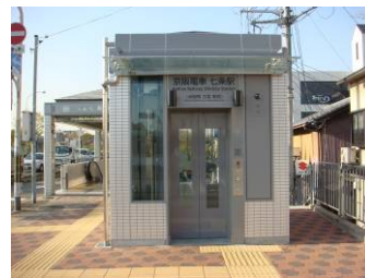
エレベータが設置された京阪七条
