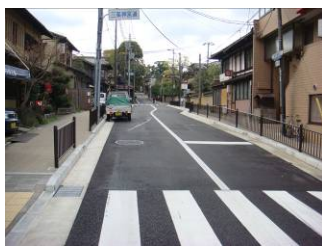
地中化工事が進む神宮道
