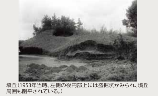
墳丘(1953年当時、左側の後円部上には盗掘坑がみられ、墳丘周囲も削平されている。)
